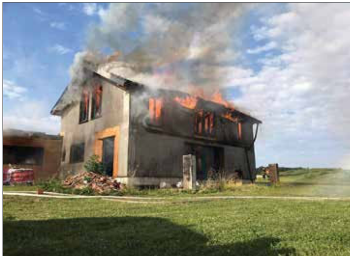
Požár rodinného domu - dřevostavby, Malá Skalice
