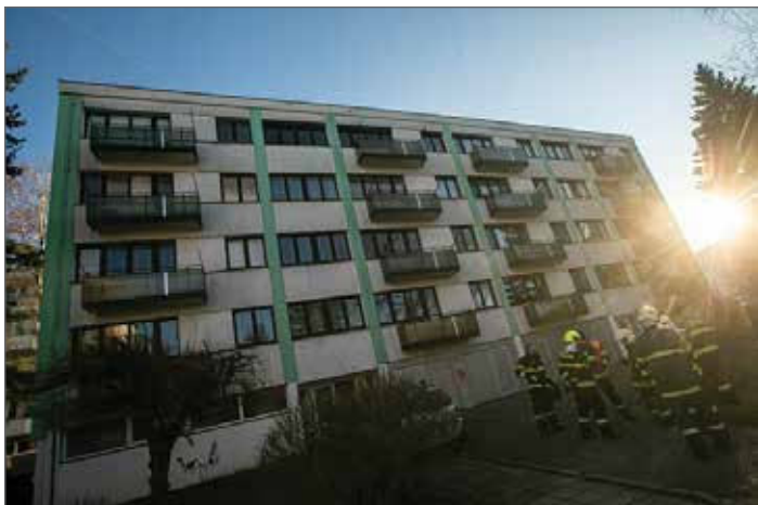
Foto: Michal Fanta - požár elektroinstalace v bytě, ulice Malecí
