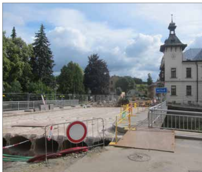
Rekonstrukce mostu v ul. 1. máje (2018)
