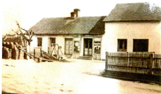
Č.p.15 - Čejpových před přestavbou
